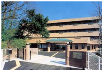
同社が施工した社会福祉施設
